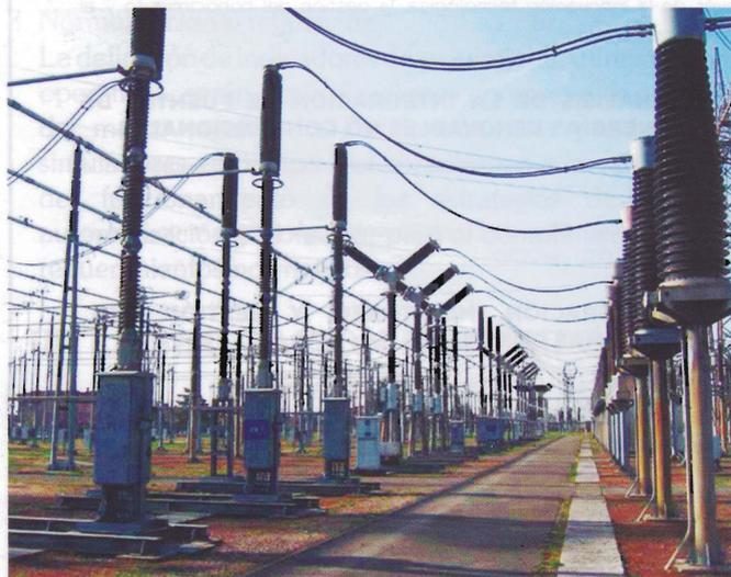
Fig. 1: Los interruptores están constantemente expuestos a factores externos, tales como el polvo, humedad, y fluctuaciones en la temperatura, los cuales pueden tener efectos negativos. Usualmente no han sido operados en años y tienen que operar confiablemente bajo condiciones de falla hasta 20 veces o más su corriente nominal en un corto periodo.
