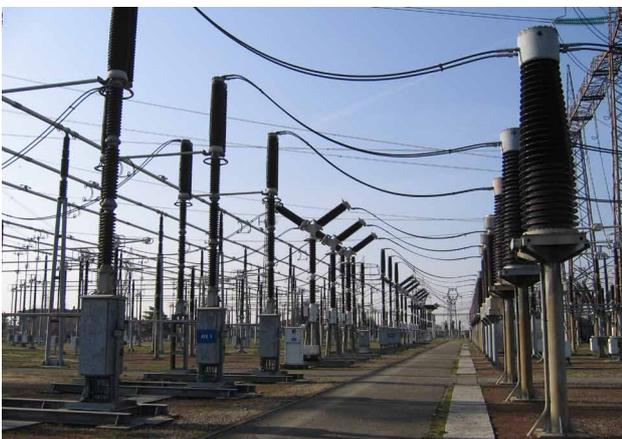
*Bild 1: Schaltgeräte sind permanent äußeren Störeinflüssen wie Schmutz, Feuchtigkeit und Temperaturschwankungen ausgesetzt. Oft werden sie über Jahre nicht betätigt und müssen dann unter Fehlerbedingungen zuverlässig schalten.*
